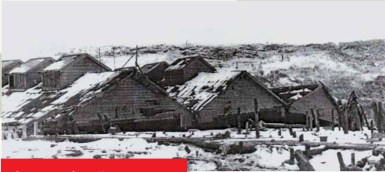
Разрушения в г.Северо-Курильске (о. Парамушир) после цунами 5 ноября 1952 г.
